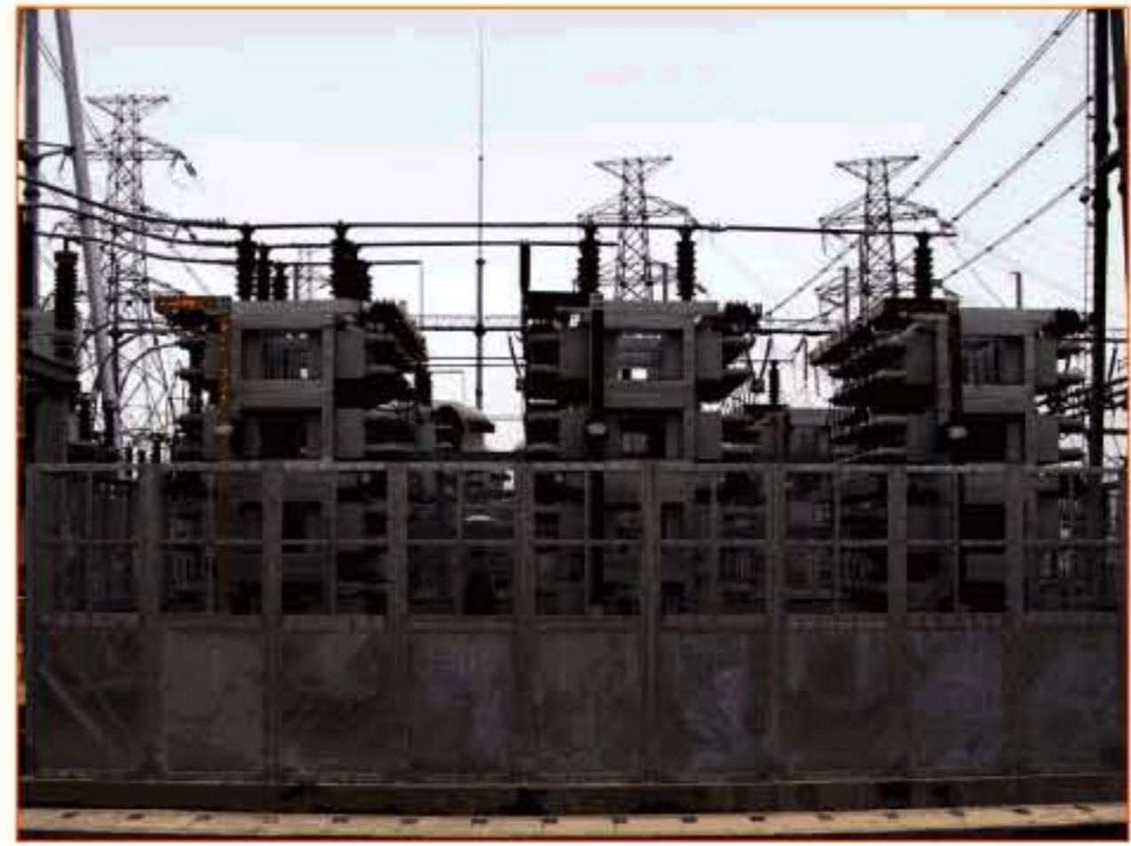
南方电网, 500kV 变电站 并补 (广东)
